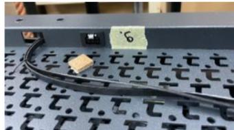
2 Stromkabel in der Länge 5,5m werden durch das rechte Rohr nach unten geführt. Im Querrohr werden sie in die dafür vorgesehenen Löcher eingesteckt. 1 Stück ist für die Vorderseite, 1 Stück ist für die Rückseite des Elements vorgesehen, um dort Wetterterminals anschließen zu können.
